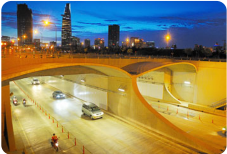
Hầm Thủ Thiêm Thu Thiem Tunnel
